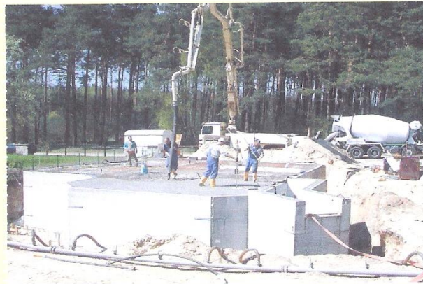
۵۴. نمونه بتن ریزی داخل دیوارها و روی سقفهای نیمه پیش ساخته
