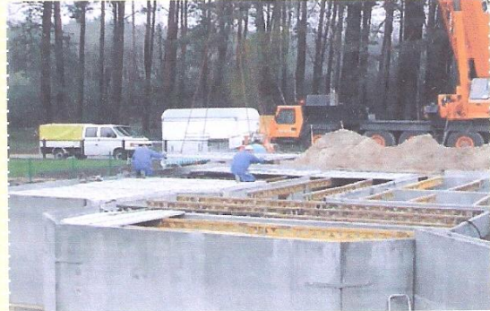
۵۲. نمونه اجرای سقف درممل سافتمان توسط جرثقیل
