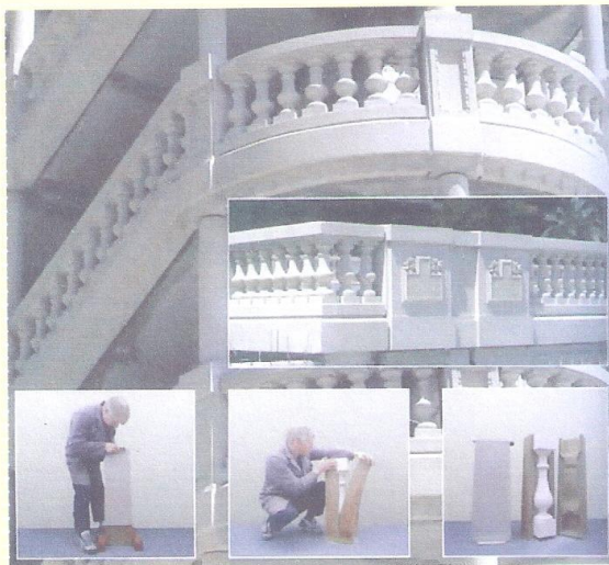
۲۷. نمونه ای از یک نرده بتنی راه پله و مرامل سافتن یکی از پایه های نرده
