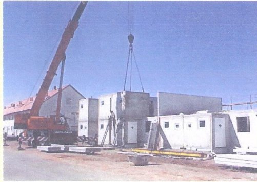
۲۴. نمونه هایی از نمونه بارگیری مامهای پیش ساخته در کارخانه و ممل به کارگاه و نصب آن در ممل
